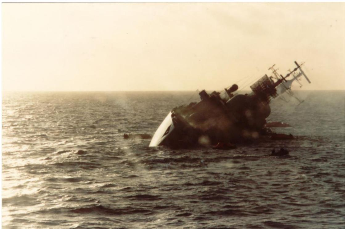
Una de las bombas que dio en el Coventry destruyó la sala de operaciones, la otra entró a la sala del motor delantero y el barco comenzó a escorarse a babor. El ataque causó 19 muertos y 30 heridos
